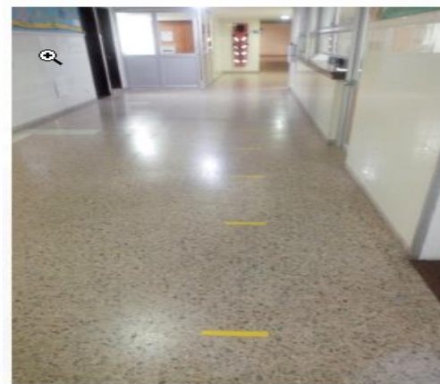
URGENCIA- 4 PISO (ASCENSOR)
